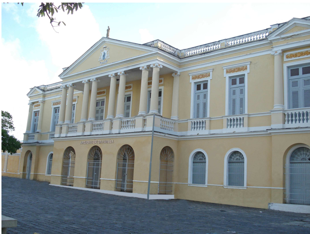
Palácio Episcopal de N. S. do Carmo, construído por Dom Adauto e inaugurado em 1906. Fonte: Foto: DIAS, Roberto Barros. Arquivo Pessoal, 2007.
